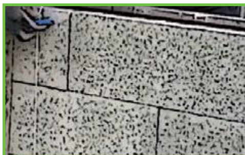
9 Vérifiez l'aplomb à mi-hauteur d'étage.
