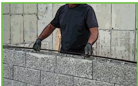
10 Positionnez les armatures horizontales dans les réservations.
